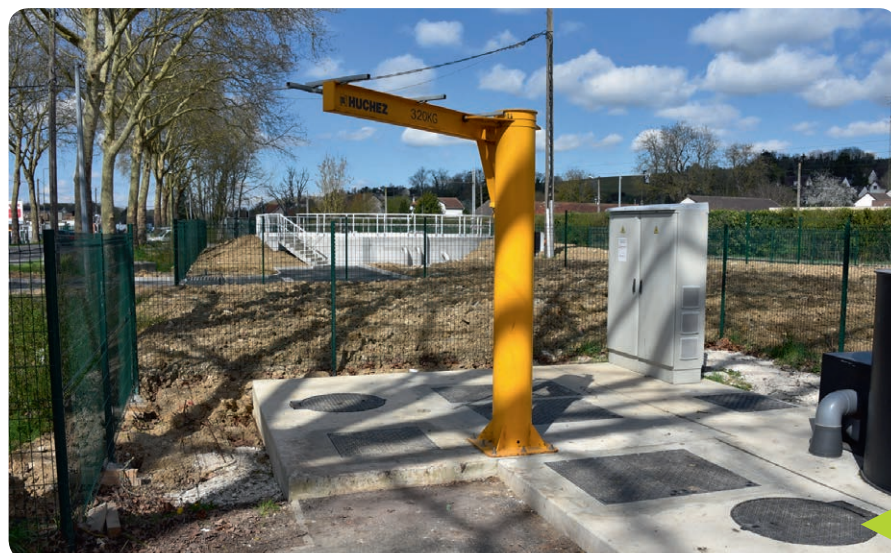
Le bassin d'orage récemment créé rue de Villiers
