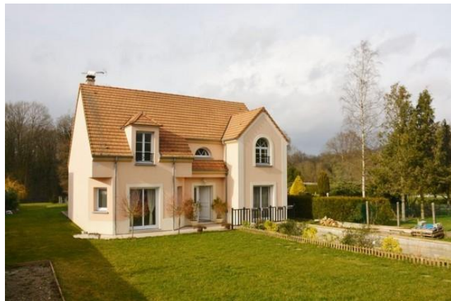
Exemple de pavillon récent
